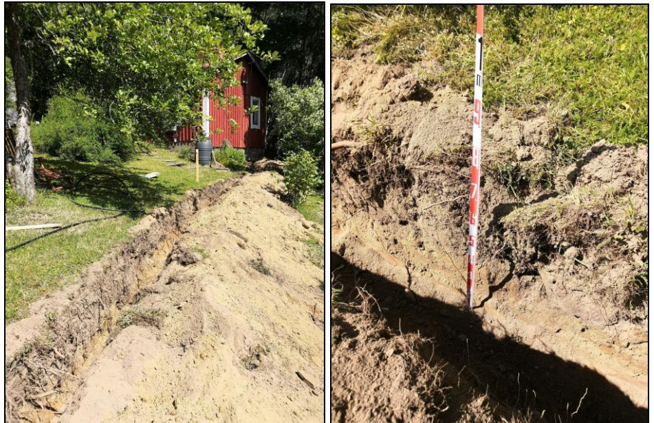
Vasen: maaperä puutar- han puolella oli hiekkaa. Oikea: kaivannon syvyys puutarhan puolella oli noin 80 cm.
