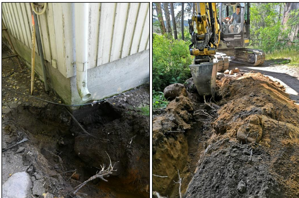
Vasen: kaivuu aloitettiin aivan talon kulmalta. Oikea: kaivaminen eteni pihatien reunaan.
