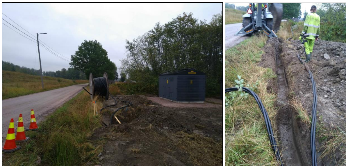
Vasen: toinen valvonta alkoi läheltä uusia muuntajakoppeja. Oikea: kaivantoa kaivetaan Halujärventien penkkaan.
