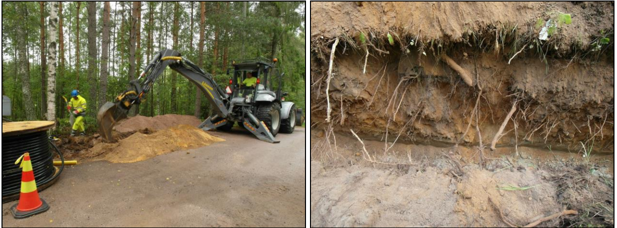
Vasen: kaivuutyö tehtiin traktorilla. Oikea: maaperä oli kaivannon alkupäässä hiekkää.
