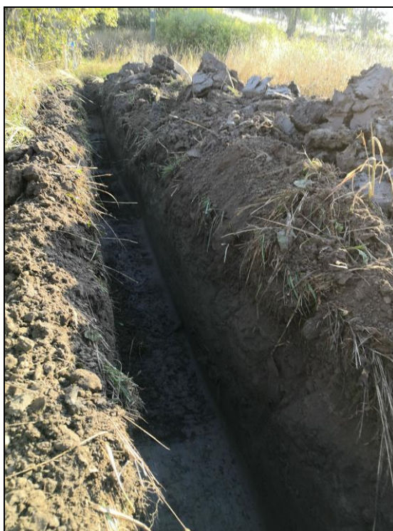
Kaivanto kokonaisuudessaan, kuvan suunta koilliseen.
