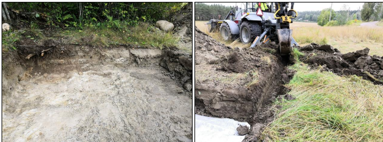
Vasen: eteläisemmän alueen kulmassa maaperä muuttui hiekkaisemmaksi. Oikea: salaojia kaivetaan.
