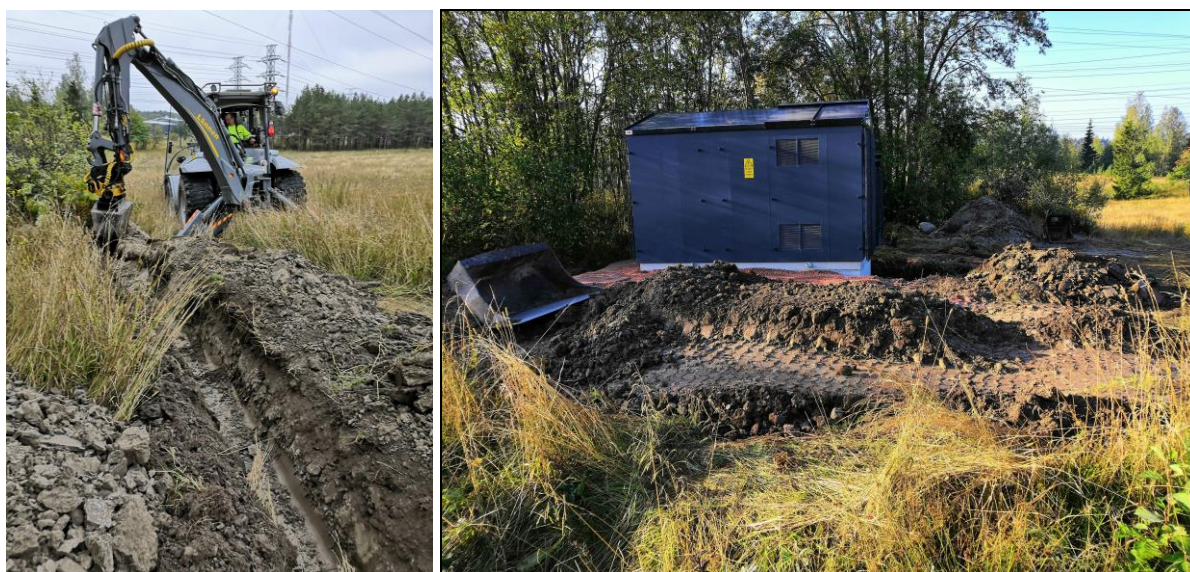
Vasen: salaojan kohdalla maaperä jatkui savisena. Oikea: muuntajakopit paikoillaan.
