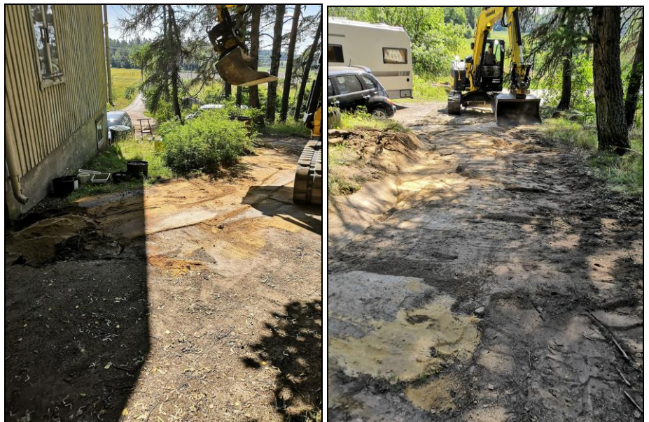
Vasen: kaivanto peitettiin välittömästi kun kaapeli oli saatu paikoilleen. Oikea: kaivannon peittäminen käynnissä pihatien ja Peringintien kulmalla.
