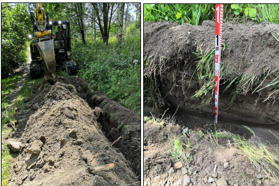
Vasen: maaperä muuttui pihatien kohdalla, pintamul- lan alapuolella oli tiivistä savea. Oikea: kaivannon syvyys pihatien kohdalla oli noin 90 - 100 cm.
