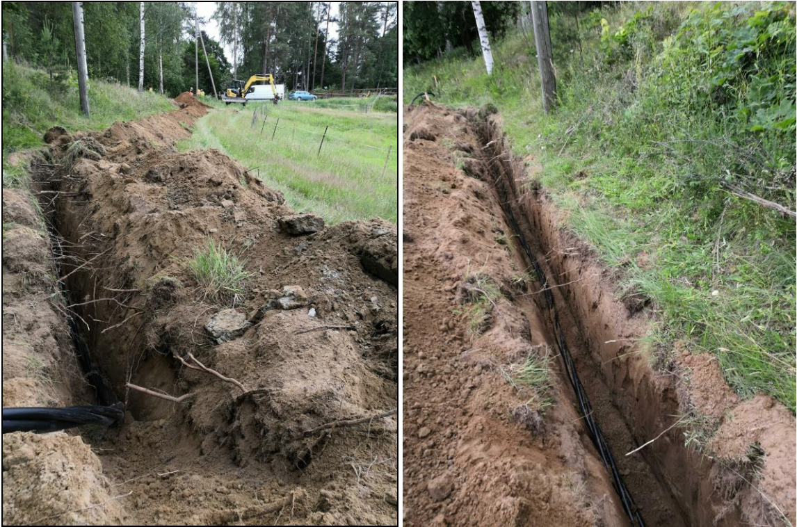
Vasen: kaapeli laitettiin paikalle heti kaivamisen jälkeen, kuvan suunta etelään. Oikea: maaperä oli koko kaivannon alueella hienoa hiekkaa, kiviä alueella oli hyvin vähän, kuvan suunta pohjoiseen.
