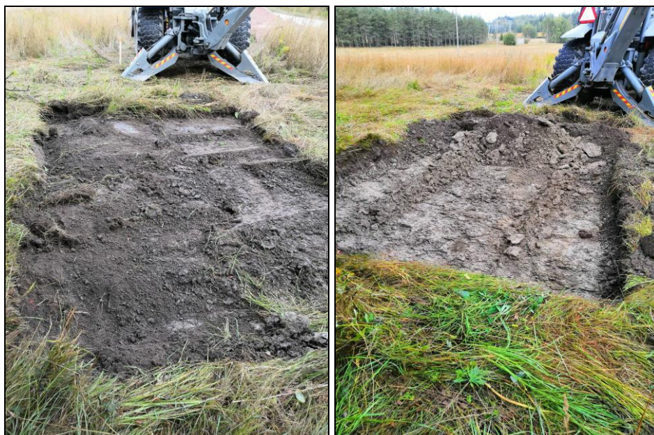
Vasen: pohjoisemman muuntajakopin alueelta nurmi kuorittuna. Oikea: peltokerroksen alapuolella maaperä osoittautui saviseksi.
