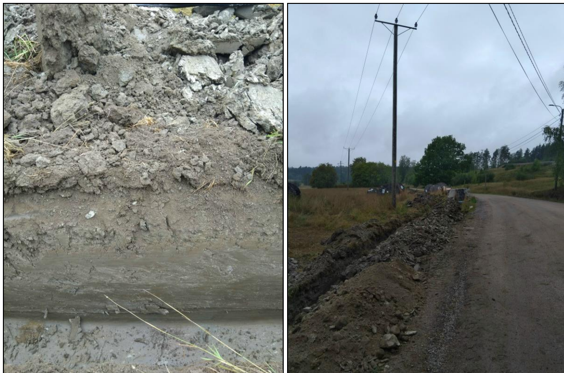
Vasen: maaperä oli kaivannon alueella savea. Oikea: kaivantoa Halujärventien eteläreunalla, kuvan suunta luoteeseen.
