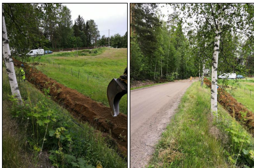
Vasen: kaapeliojan kaivaminen käynnissä. Oikea: kaivanto tehtiin lähelle melko jyrkkää tienpenkkaa.
