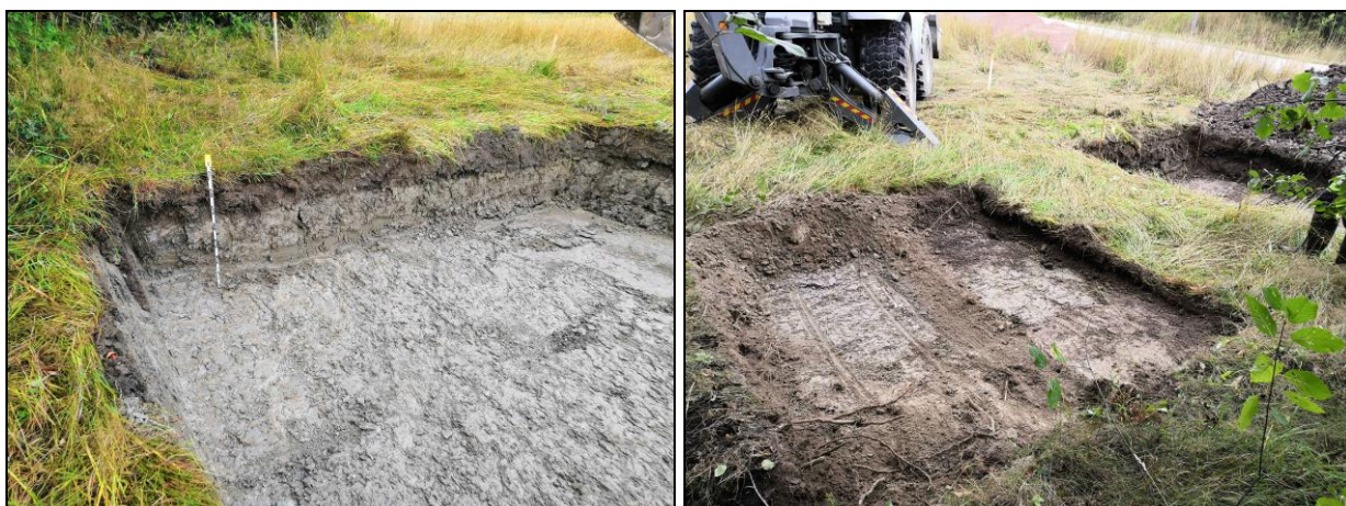
Vasen: pohjoisemman muuntajakopin perustus kaivettu valmiiksi. Oikea: eteläpuoleisen muuntajakopin kohtaa kaivetaan.
